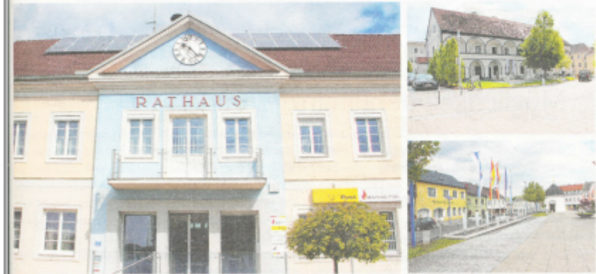
Am Hauptplatz: Fotovoltaik-Anlage auf dem Rathaus-Dach, die Straßen bleiben heute menschenleer
